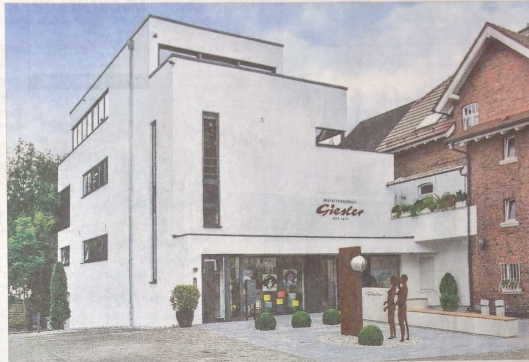
Der Platz vor dem Eingang des neuen Objektes wird mit einem 2,70 m hohen Kunstwerk aus Cortenstahl und zwei Skulpturen aus verrostetem Stahl geschmückt.
